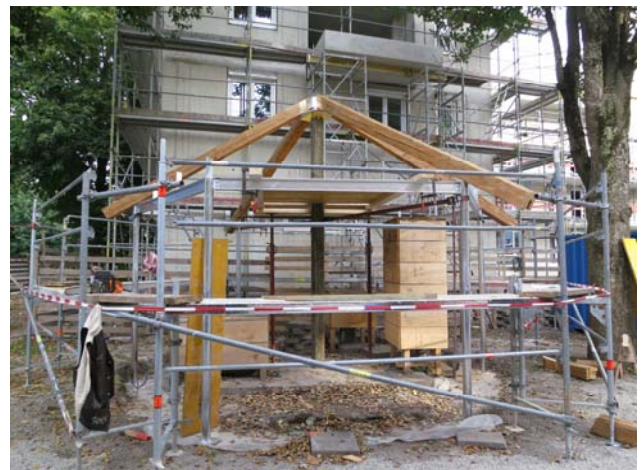
Der „Rohbau“ der Überdachung
