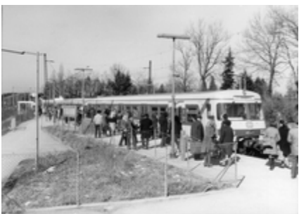
Bahnsteig der neuen S-Bahn Haltestelle
