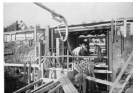
Bau der Bahnstufenunterführung
