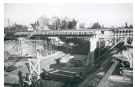
Bau der Bahnunterführung Freyastraße 1973-1975
