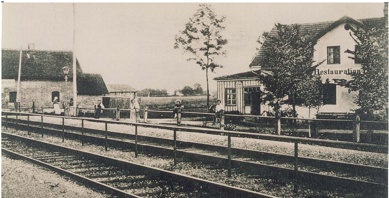
Der Haltepunkt Gröbenzell kurz nach 1900. Links der Bahnübergang (heute Unterführung Kirchen-/Bahnhofstraße).
